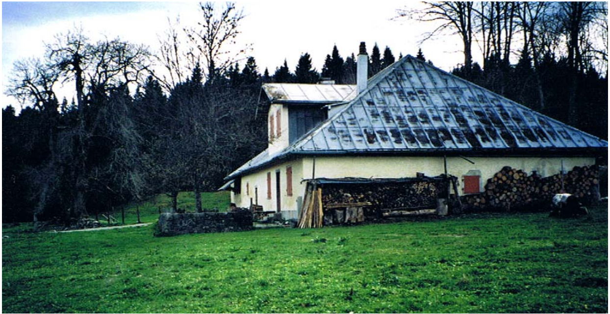
Grande-Dernier Béquet, façade nord est. Vu les abords du chalet, il ne serait pas impossible que celui-ci n'accueille plus de bétail mais serve uniquement de résidence secondaire.
