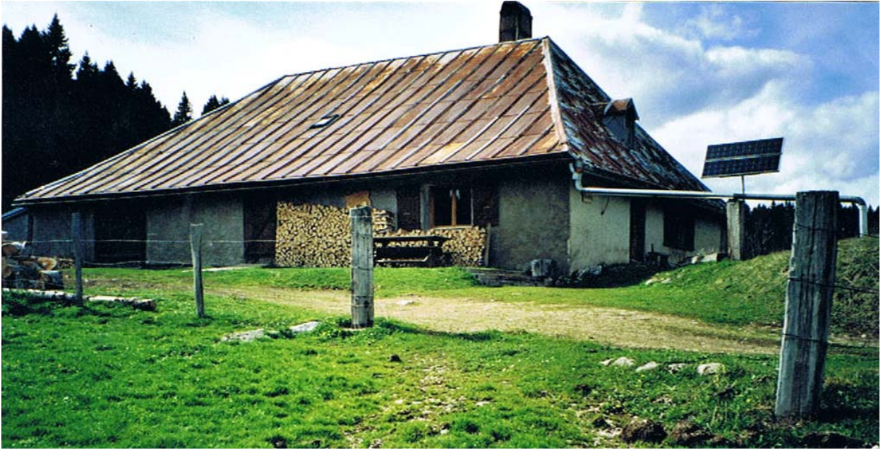
Gentile Neuve, alpage traditionnel avec toit à 4 pans irréguliers
